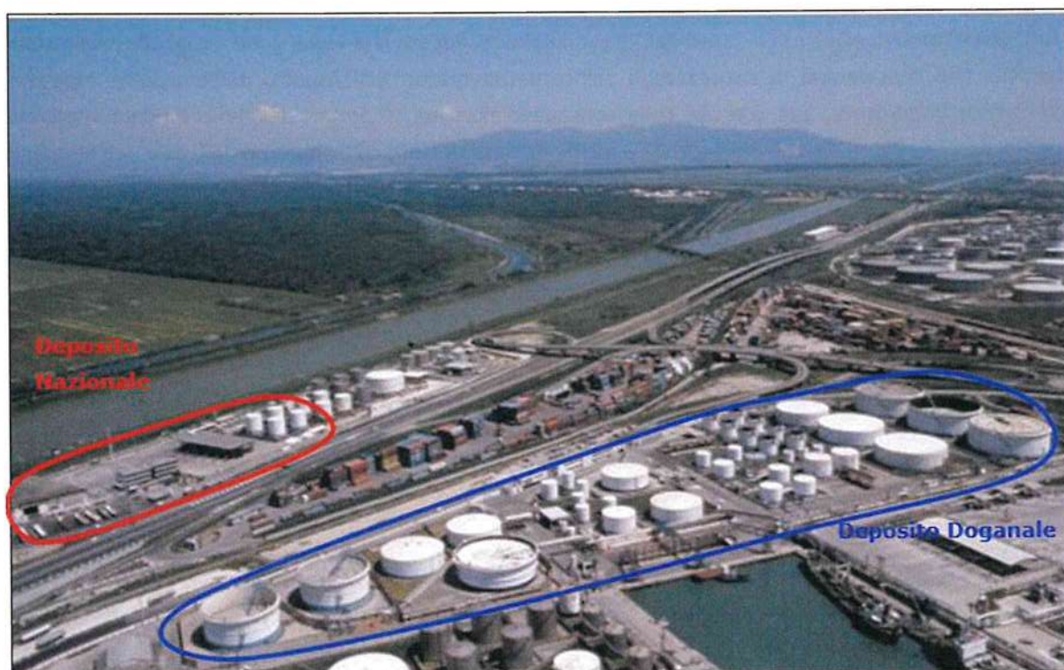
Figura 1: Vista aerea dei due depositi
